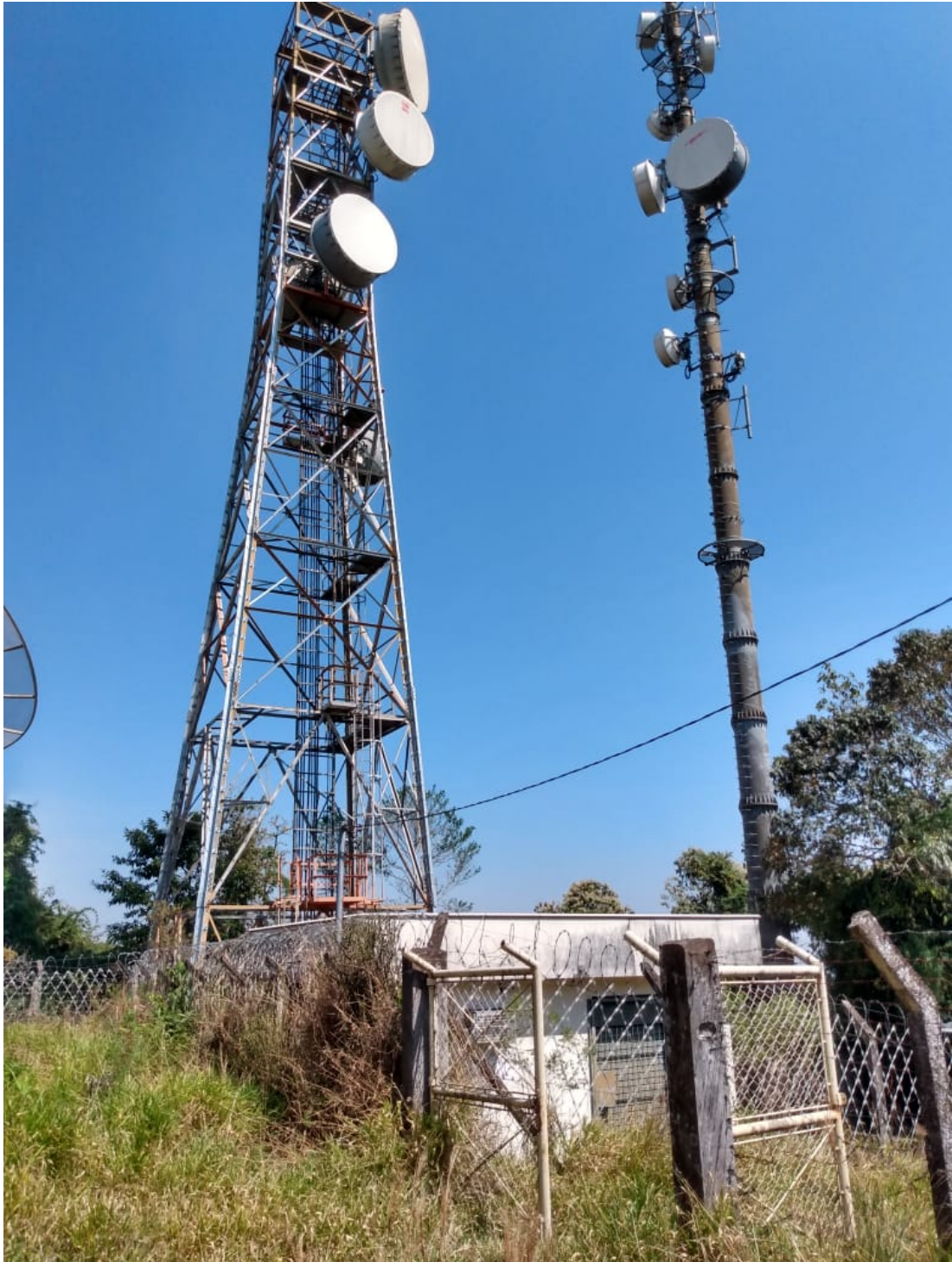
Figura B.5: Foto do local de instalação do BUC do satélite SES-14.
